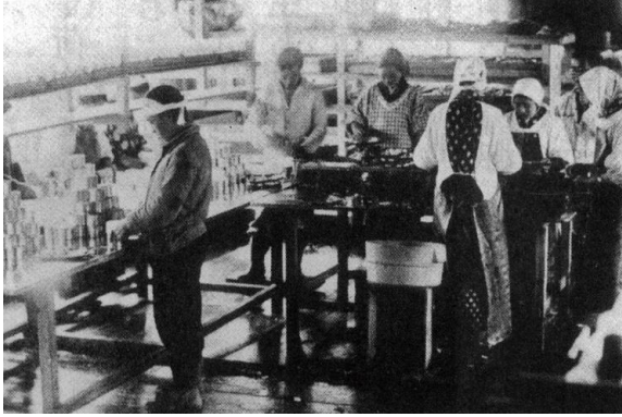
国後島のかん詰作業風景(昭和9年)
